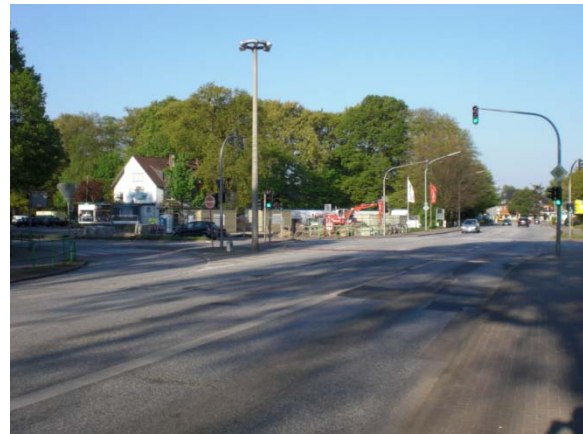
Der Umbau zum Kreisverkehr steht bevor
