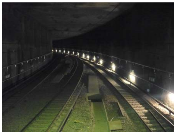
Die Gleise nach Ohlsdorf liegen schon!
